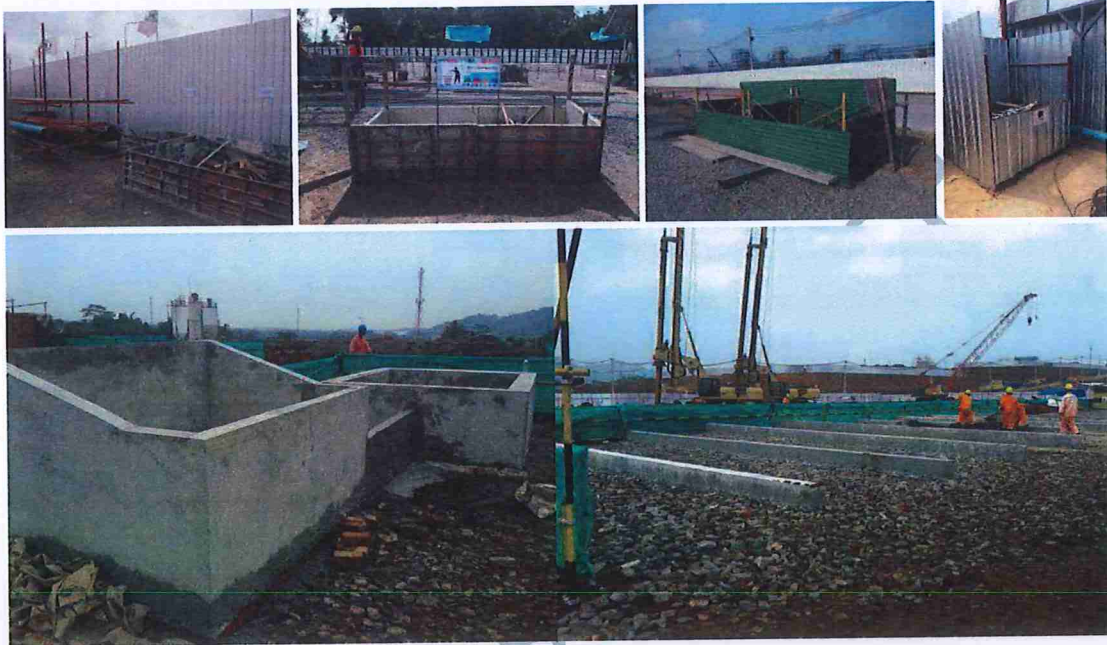
ภาพตัวอย่างการแบ่งพื้นที่สำหรับการกองวัสดุและคอกสำหรับใส่เศษเหล็ก
